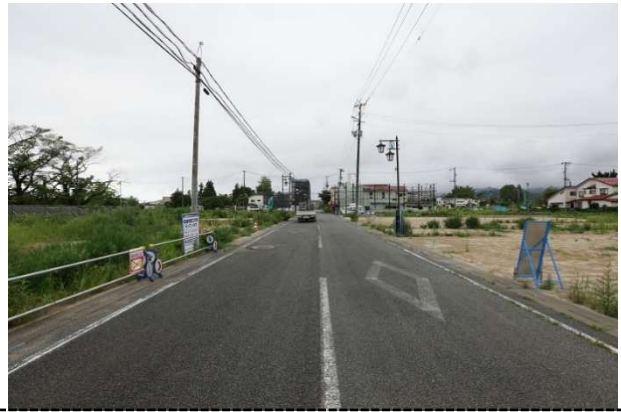
大熊町大野駅前商店街 2年前には人のいない駅前商店街が続いていたこの場所も解体が進みほとんどが空き地に。今頃は何の建物も残っていないだろう。
